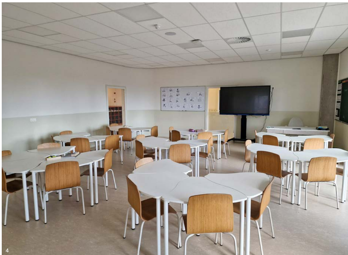
4 De plafondpanelen zijn voorzien van een akoestisch vlies.
