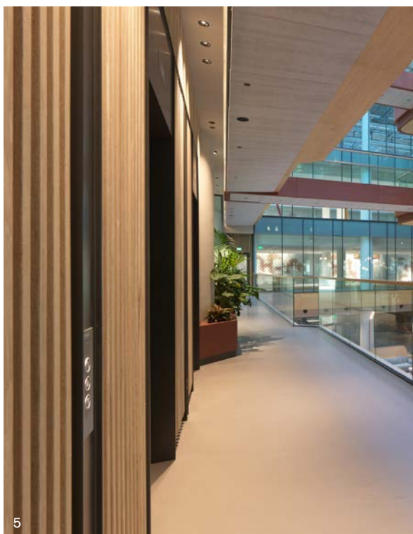
5 Profinish maakte de houten (fraké) lamellen op de wanden.
